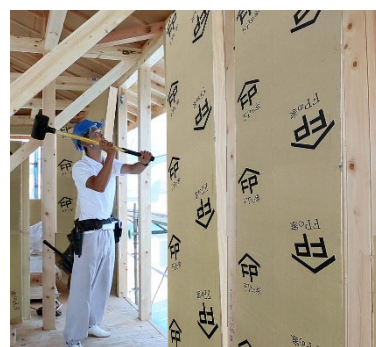
▲FP パネルの施工風景
