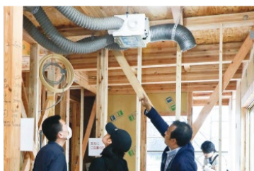
【構造見学会】完成後には見ることのできない建物の構造部分を確認いただけます。
